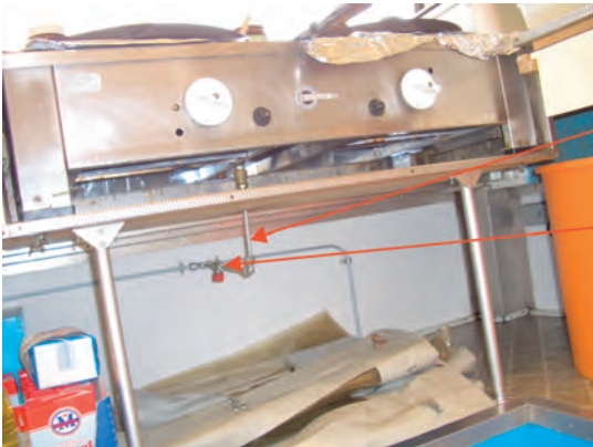
Abb. 18: Crepe-Backgerät mit Anschluss an eine Rohrleitung und Absperreinrichtung
