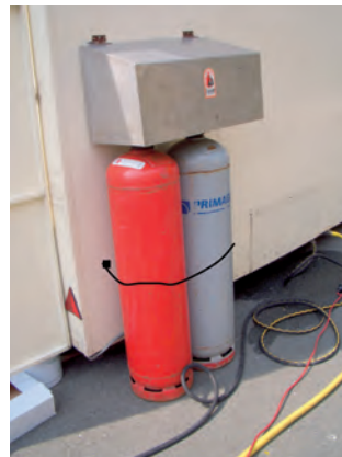
Abb. 5: Schutzhaube; jedoch noch zu beseitigende Stolperstellen (Schlauchleitungen)
